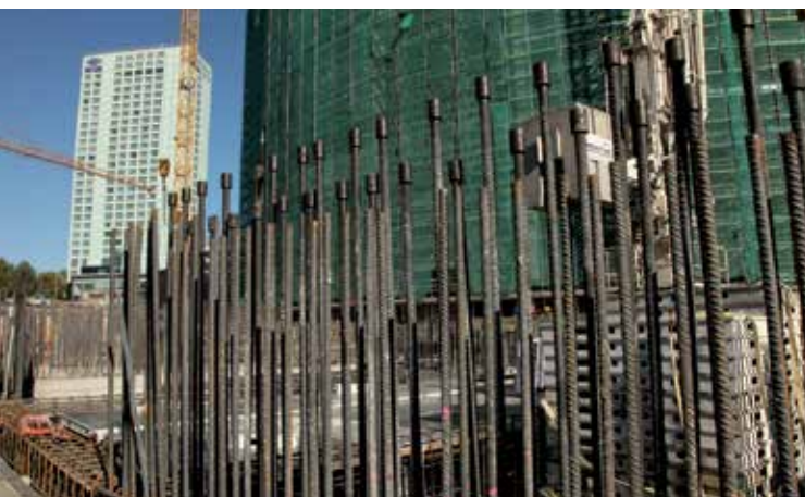
ZBROJENIE SKRĘCANE FORTEC – BUDOWA WARSZAW SPIRE
