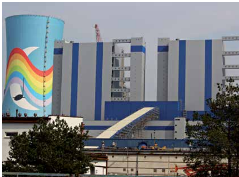
WIDOK OGÓLNY NA NOWE BLOKI W ELEKTROWNI OPOLE
