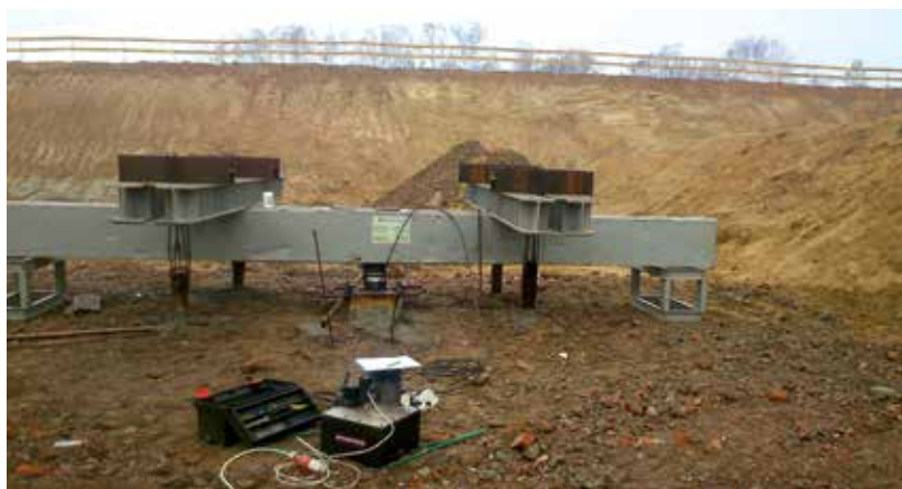
PRÓBNE OBCIĄŻENIE, KRAKÓW
