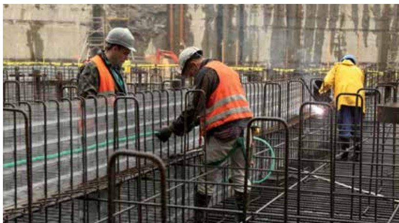
MONTAŻ SYSTEMÓW USZCZELNIAJĄCYCH - BUDOWA MUZEUM II WOJNY ŚWIATOWEJ
