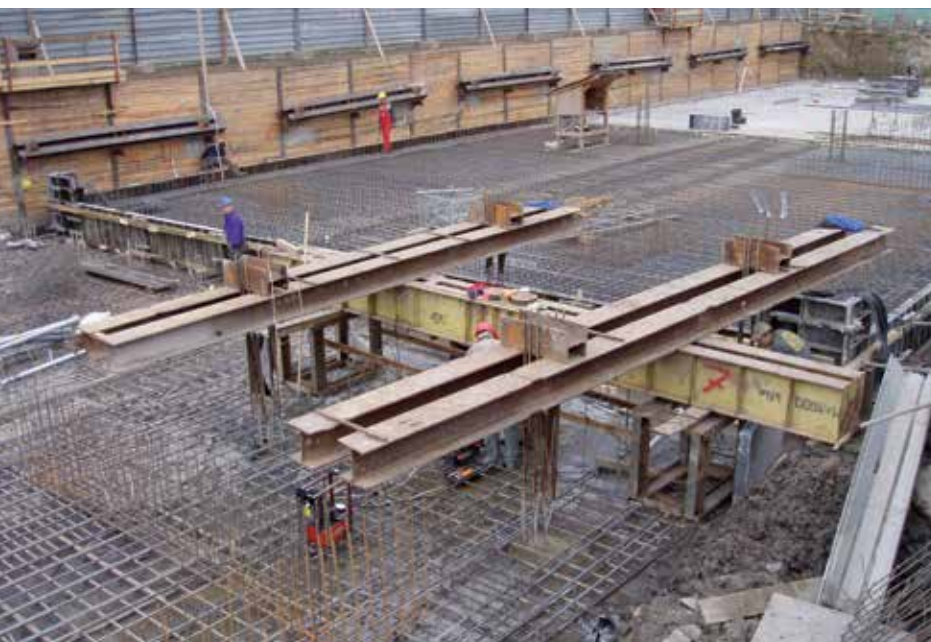
PRÓBNE OBCIĄŻENIE, WROCŁAW
