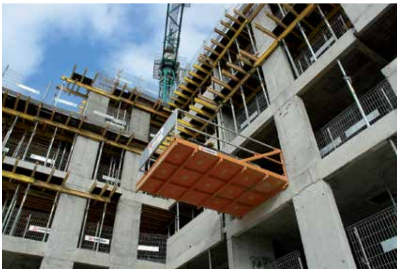
PODEST ROZŁADUNKOWY I SYSTEM ZABEZPIECZEŃ SECUMAX® - OSIEDLE W WARSZAWIE
